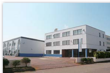
工場全景 (環境に配慮した建物です)
