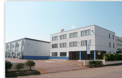
工場全景(環境に配慮した建物です)
